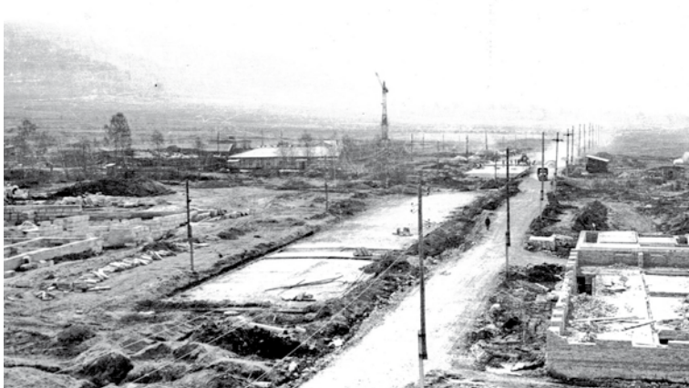
Начало строительства пр. Чернышевского (ныне — пр. Макеева)
